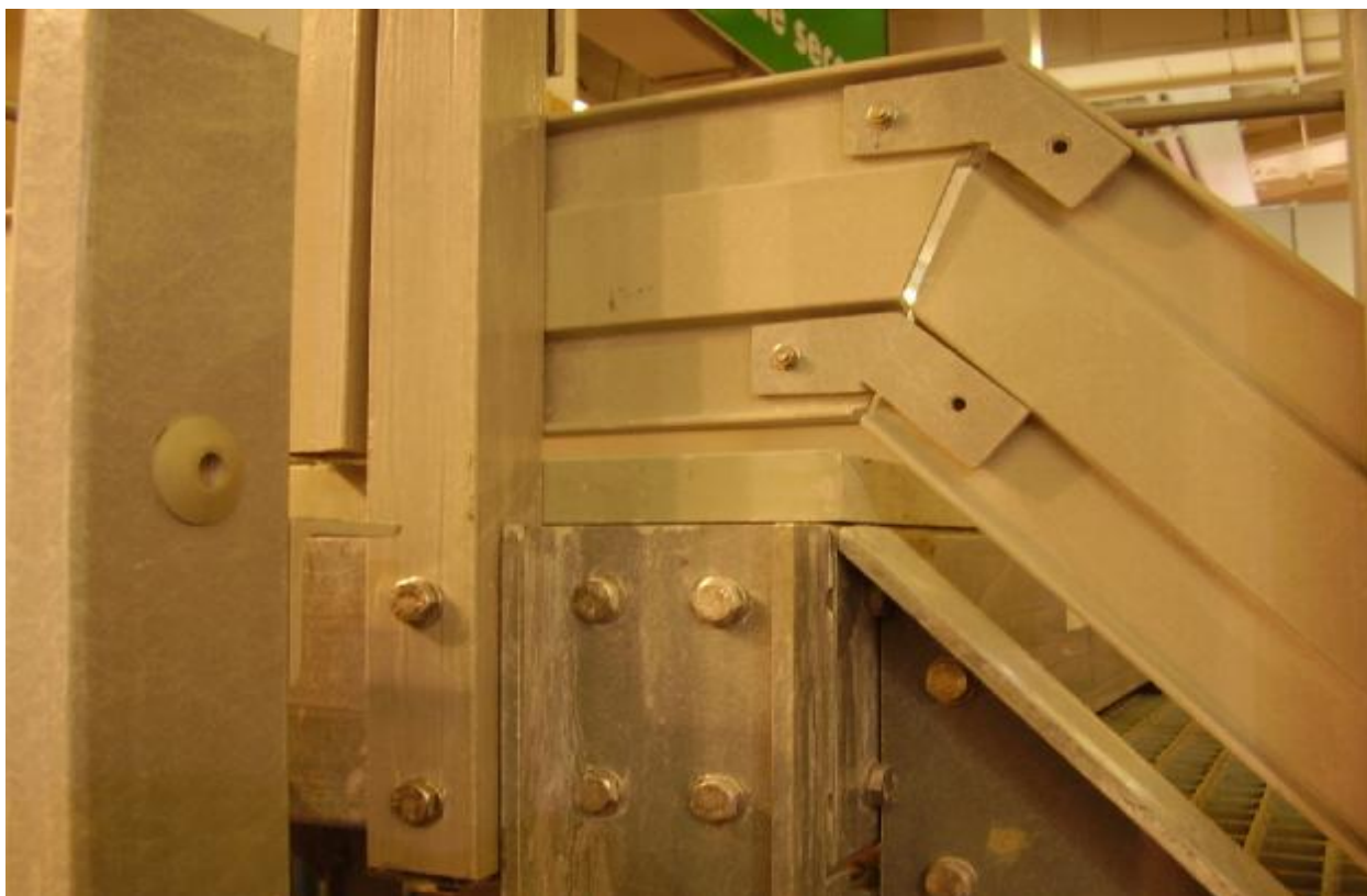
Obr. 26: Příklad spoje dvou úhelníků za použití desky a dalšího úhelníku
