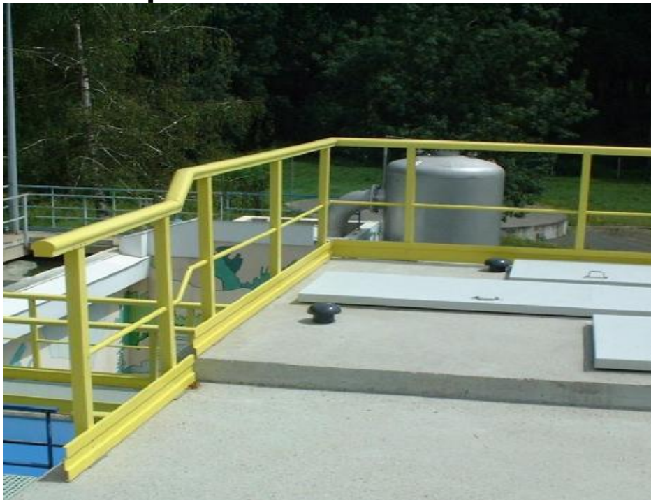
Obr.19 – Příklad aplikace ochranného zábradlí
