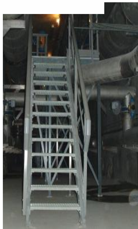
Obr. 24 Konstrukce již hotového schodiště
